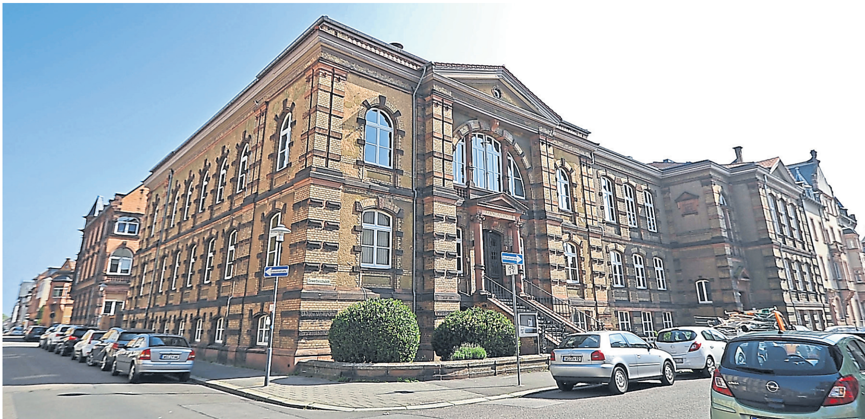
Die alte Gewerbeschule kann seit zweieinhalb Jahren wegen Brandschutzmängeln nicht genutzt werden.
